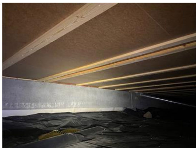
Allmän bild krypgrund
