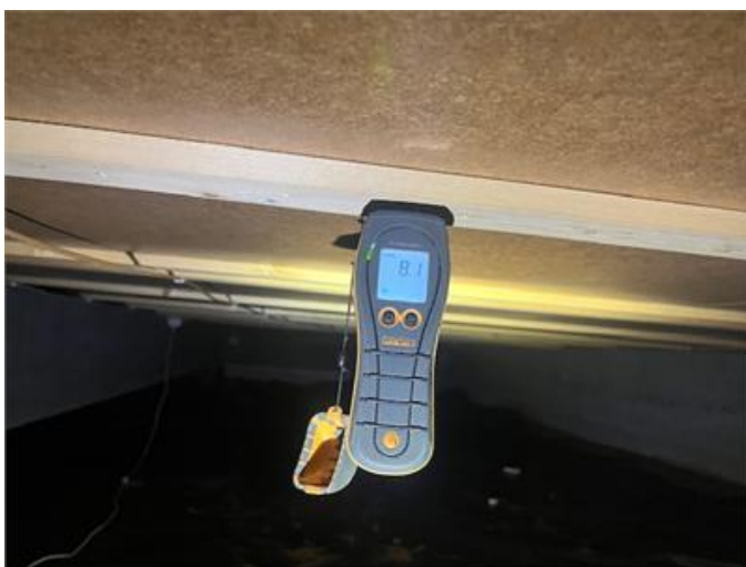
Allmän bild krypgrund
