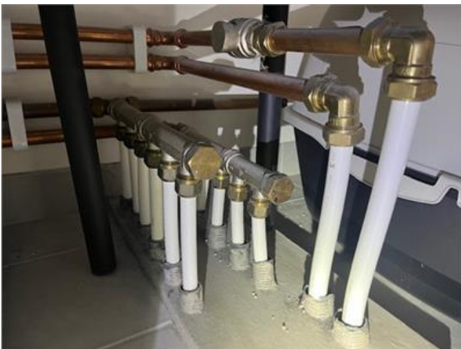
Rörsamling till golvvärmen monterad på klack utan genomföringshylsa.
