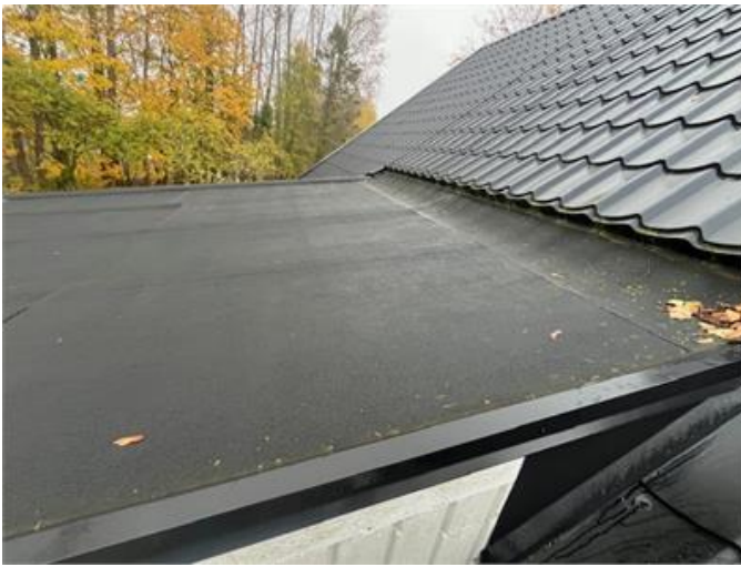
Takpappen och plåttaket var utan något att anmärka på
